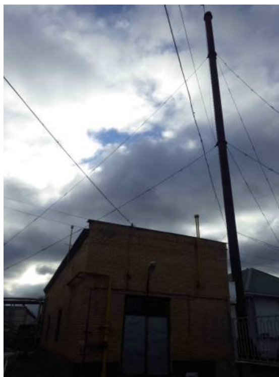
Рисунок 1.24 – Общий вид котельной Городской бани АО «Одинцовская теплосеть»
