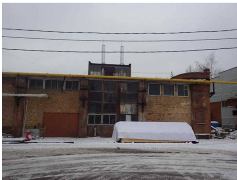
Рисунок 1.40 – Общий вид котельной №2 ОАО «ВЗОИ»
