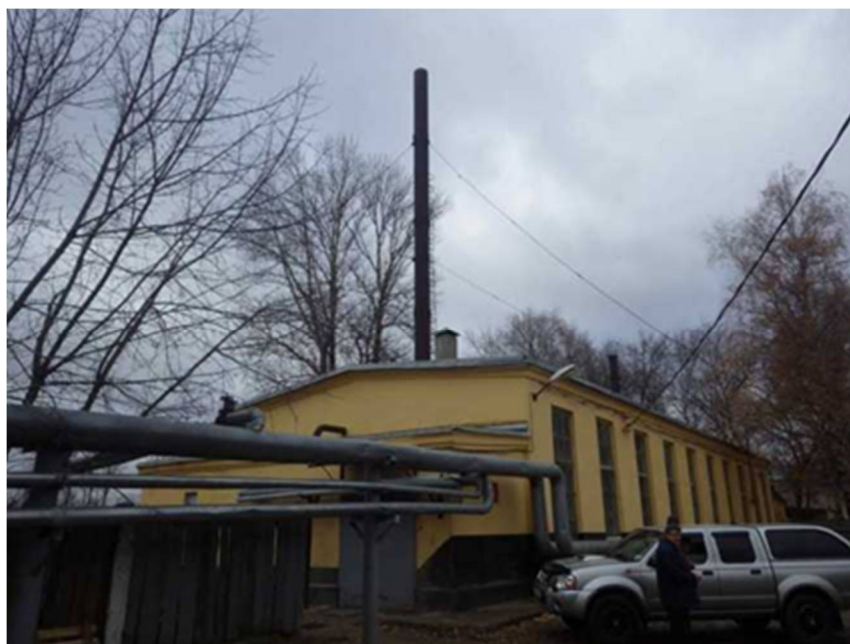
Рисунок 1.26 – Общий вид котельной «Одинцово-1» АО «Одинцовская теплосеть»
