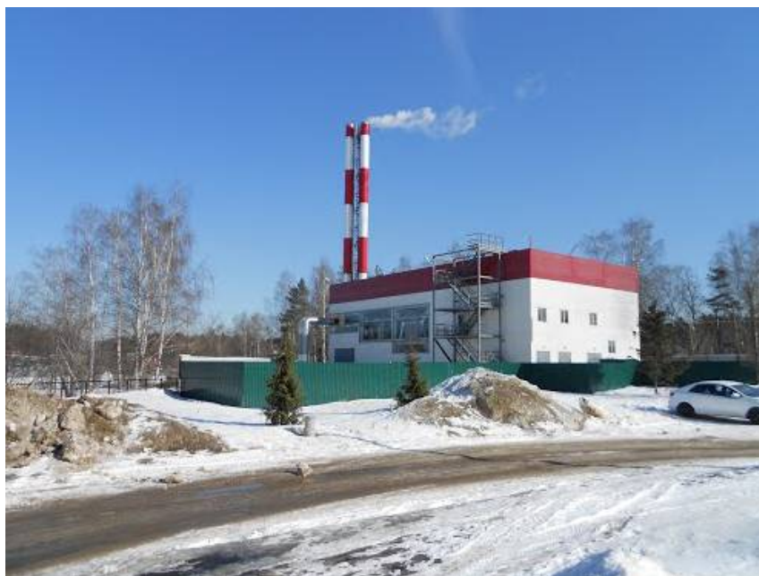
Рисунок 1.45 – Общий вид котельной №9 АО «Одинцовская теплосеть»
