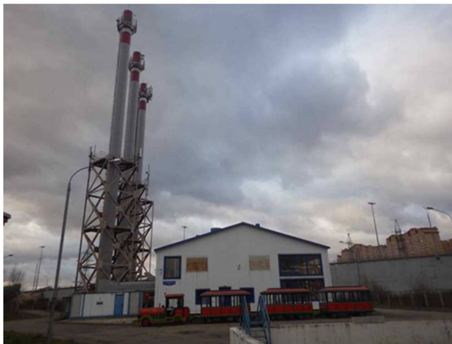
Рисунок 1.46 – Общий вид котельной №2 АО «Ресурс»
