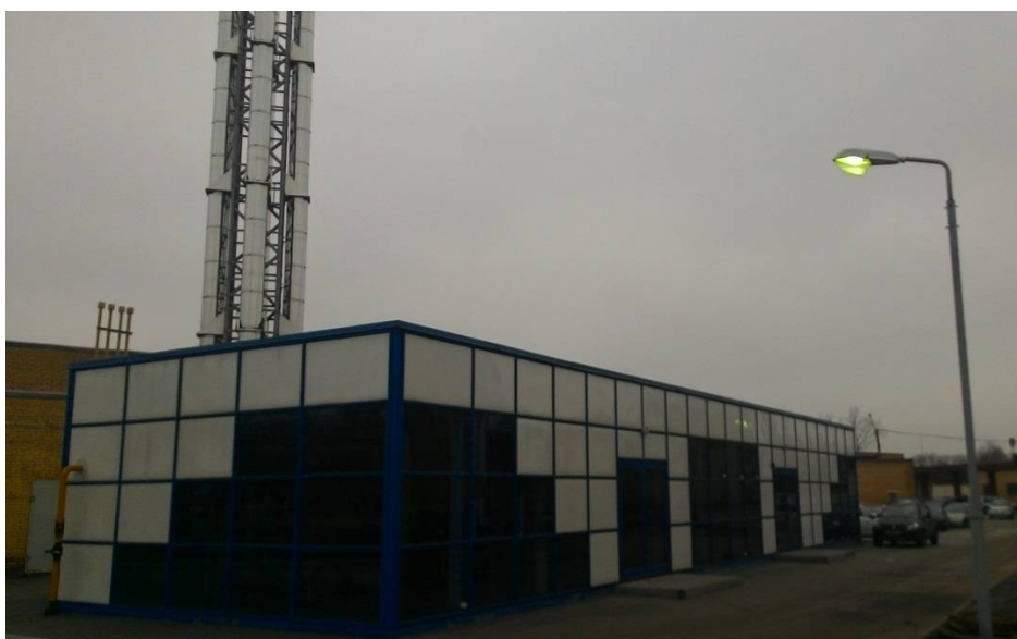
Рисунок 1.52 - Общий вид БМК в/г №20
