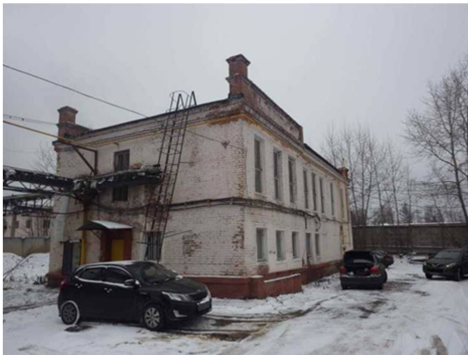
Рисунок 1.38 – Общий вид котельной №1 ОАО «ВЗОИ»
