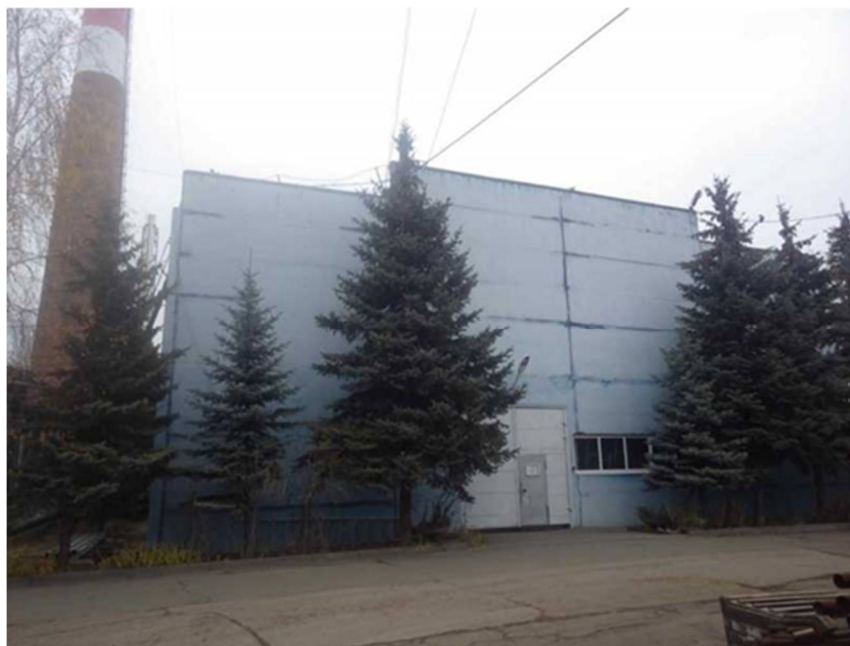
Рисунок 1.36 – Общий вид котельной ООО «МНЗ»
