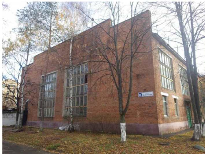
Рисунок 1.9 – Общий вид котельной №1-а АО «Одинцовская теплосеть»
