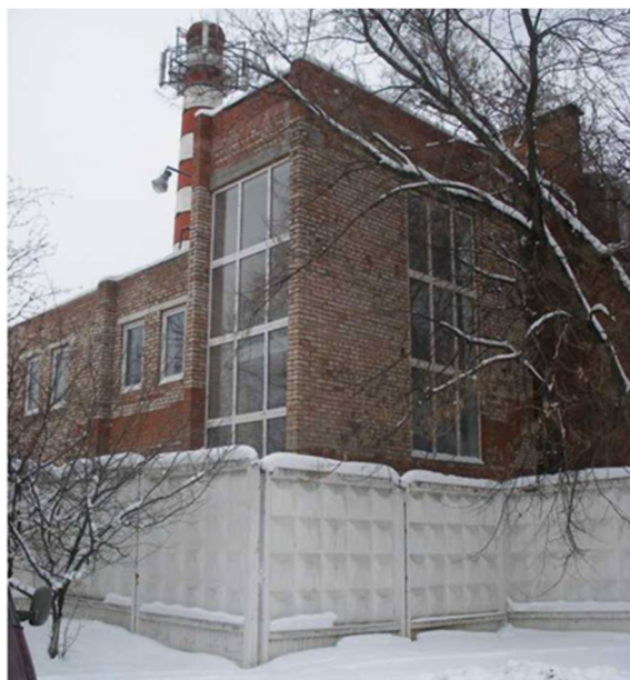
Рисунок 1.7 – Общий вид котельной №1 АО «Одинцовская теплосеть»
