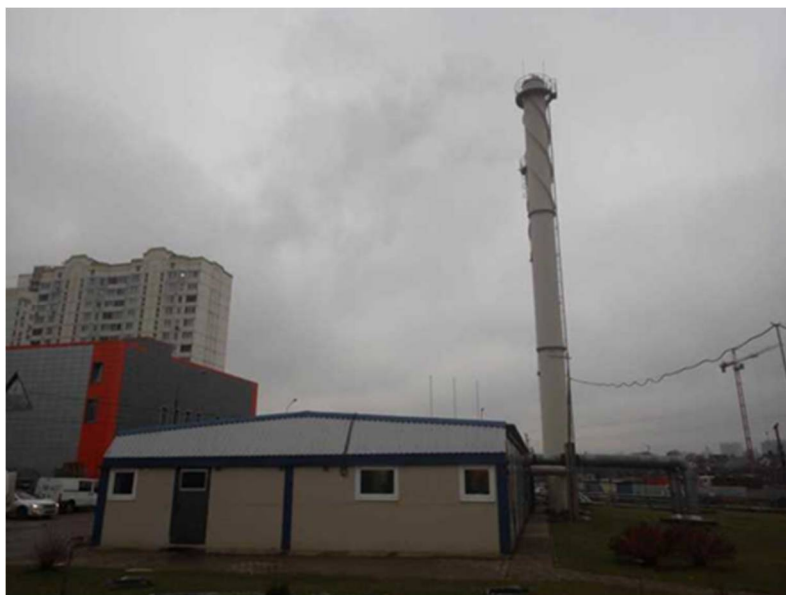
Рисунок 1.34 – Общий вид котельной «Трехгорка» АО «Одинцовская теплосеть»
