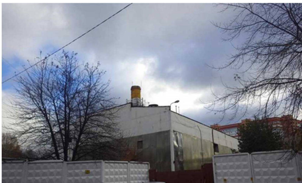
Рисунок 1.15 – Общий вид котельной №7 АО «Одинцовская теплосеть»
