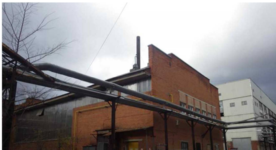
Рисунок 1.14 – Общий вид котельной №6 АО «Одинцовская теплосеть»
