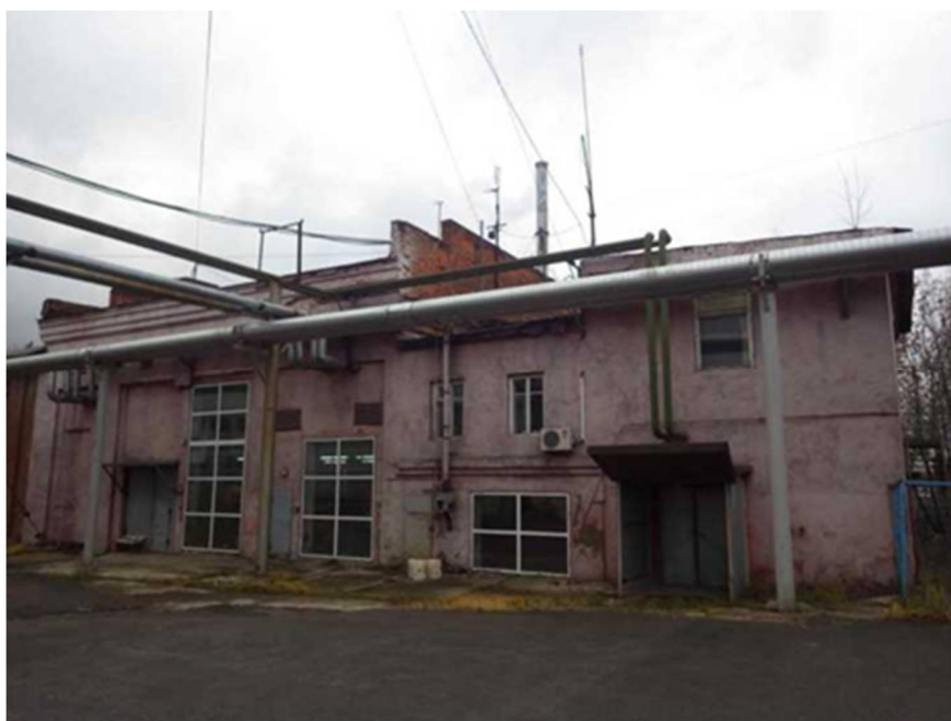
Рисунок 1.43 – Общий вид котельной ООО «БЗРИ»
