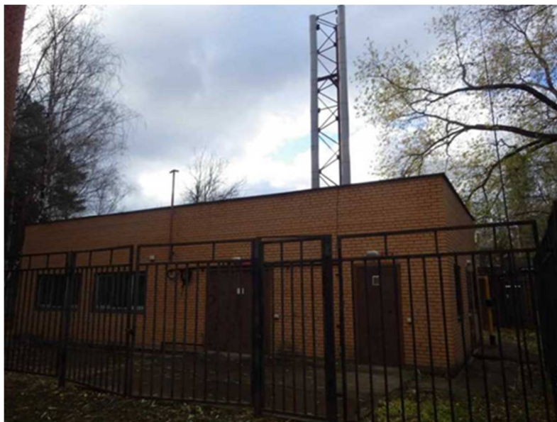
Рисунок 1.28 – Общий вид котельной д/о «Озера» АО «Одинцовская теплосеть»
