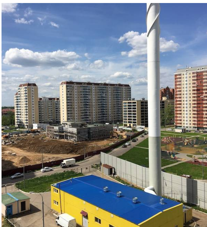
Рисунок 1.51 - Общий вид котельной мкр. Немчиновка
