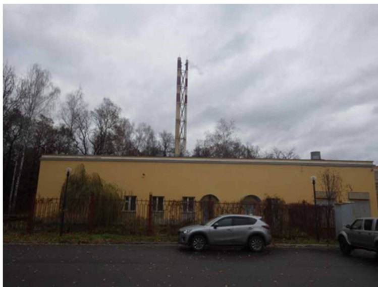
Рисунок 1.21 – Общий вид котельной «Университет» АО «Одинцовская теплосеть»
